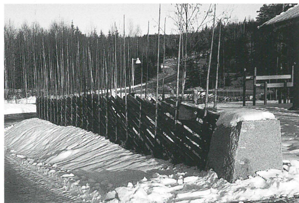
Fig. 44 b Rasteplass. Skigarden er avsluttet med en granittavviser for å hindre påkjørsel. (Ved Sperillen i Oppland)
