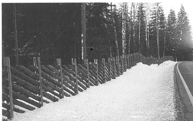
Fig. 321 Trykkimpregnerte staur, ståltrådsurringer og horisontalt avkuttet hon gir en kollete og altfor frisert skigard. Uheldig løsning
