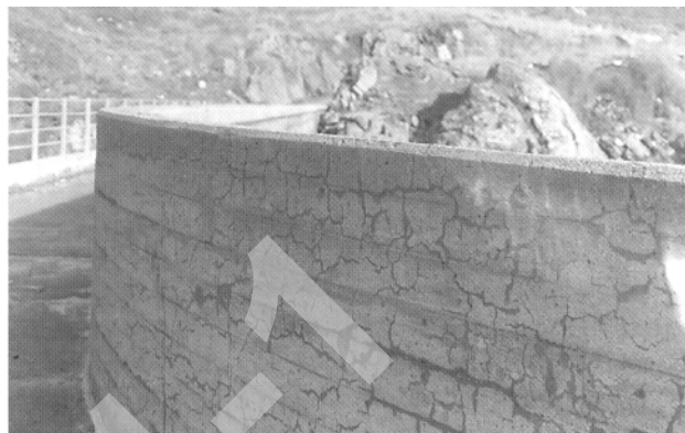
Fig. 11 a Rissmønster på 23 år gammel dam, over 1 000 m.o.h.
