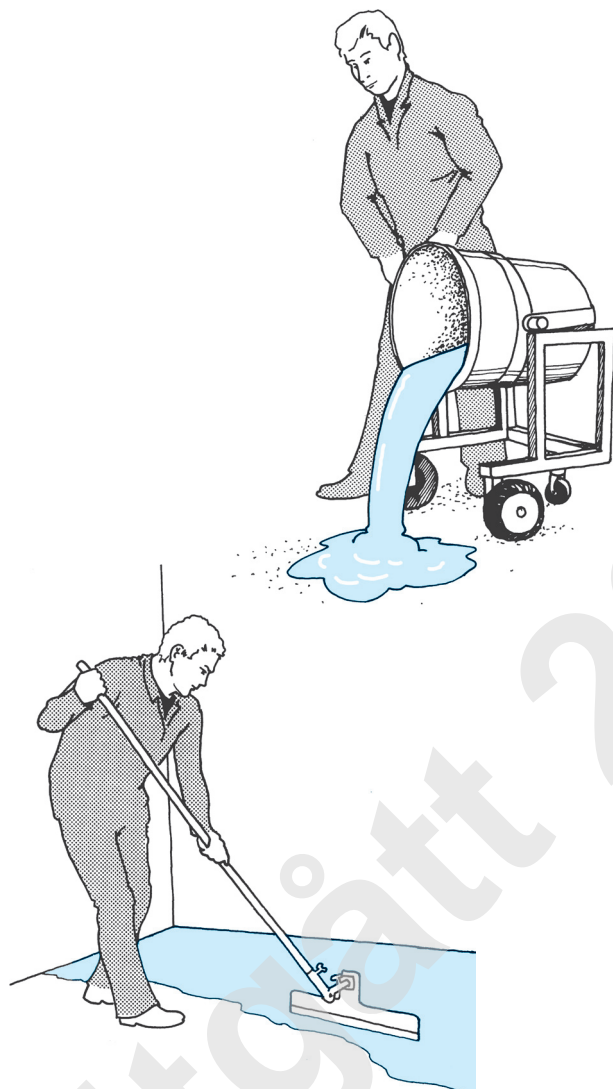
Fig. 73 c Utlekking av selvutjevne masse Massen helles ut av blandekaret, flyter lett utover golvet og fordeles med nivårake eller tannsparkel.
